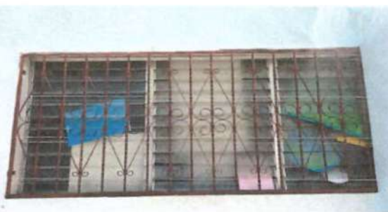
Foto 5: VENTANAS Reparación de balcones metálicos, incluyendo fijaciones, pintura y soldadura
