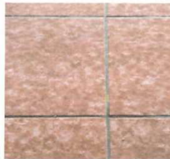
Foto 4: SUSTITUCIÓN DE AZULEJO Sustitución de piso Tipo: azulejo, trabajo de nivelación, instalación alineada y sizado en juntas. En meson de cocina
