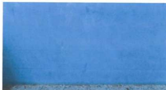
Foto 2: PINTURA EN MUROS INTERIOR Y EXTERIOR Preparación de la superficie y aplicación de pintura a dos manos, en paredes interiores y exteriores del establecimiento.
