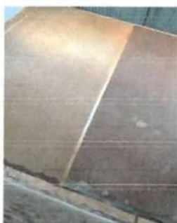
Foto 3: REPARACIÓN DE MUROS Reparación de muro de tabala yeso, incluye refuerzo.
