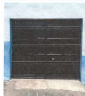
Foto 6: MANTENIMIENTO A PORTONES Sustitución a portón de ingreso, material: metálico, incluye: bisagras y sistemas de cierre.
