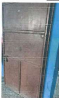
Foto 1: PUERTAS Mantenimiento a puerta metálica existente retiro de óxido, suciedad y pintura deteriorada; incluye cepillado, lijado y aplicación de pintura
